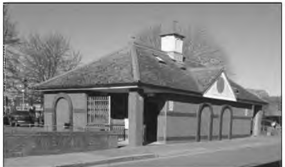
Stembrook Toilet Block
